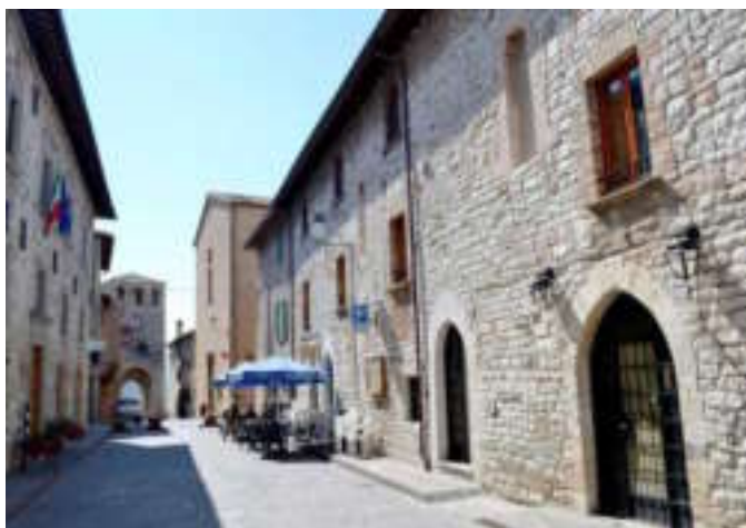
L'ostello del Parco e il borgo di Costacciaro
