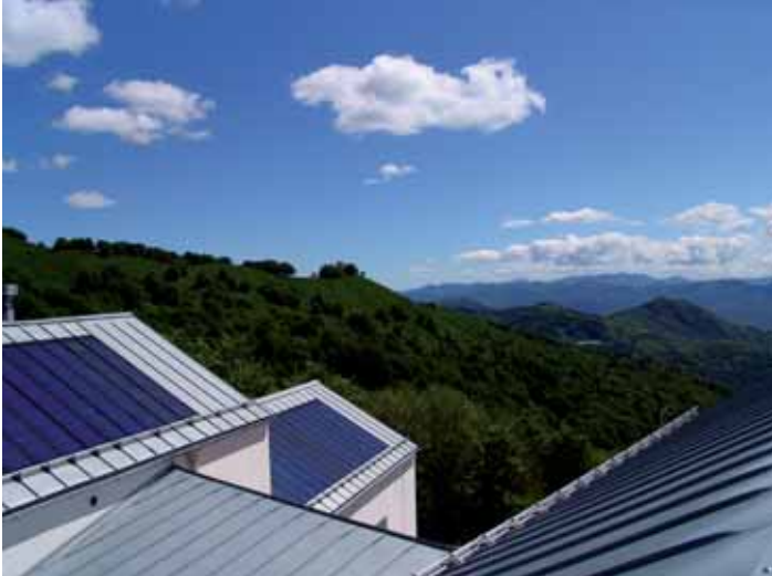
Dall'energia del sole all'energia elettrica: i pannelli fotovoltaici al Rifugio Parco Antola
