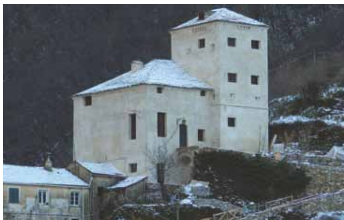
Il Castello di Senarega dopo il restauro
