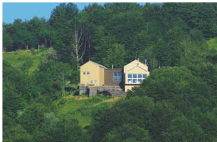
Il Rifugio dopo la ristrutturazione delle facciate.
