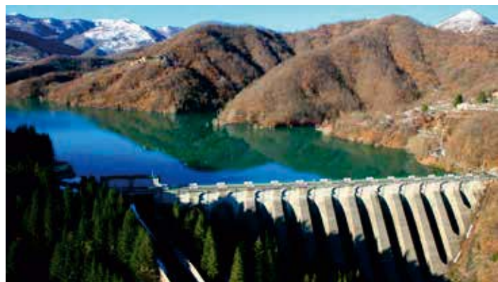
La diga del Brugneto dall'elicottero. Foto di M.Carraro
