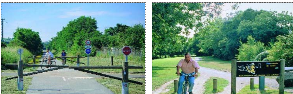
Figura 4. Protezioni agli ingressi delle greenway (figure tratte dalla guida della Commissione europea).
