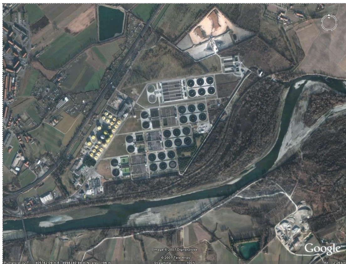
Figura 8. Impianto di depurazione acque lungo il Po. Settimo Torinese (Torino).
