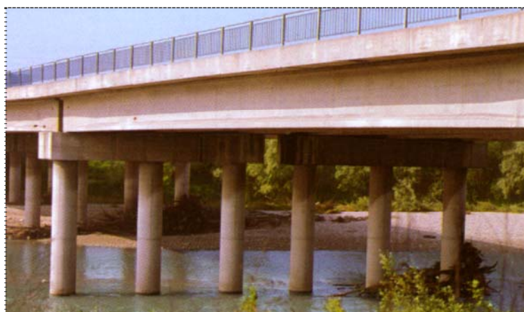
Figura 16. Ponte sulla Stura di Lanzo lungo il raccordo autostradale per l'Aeroporto di Caselle. Torino.
