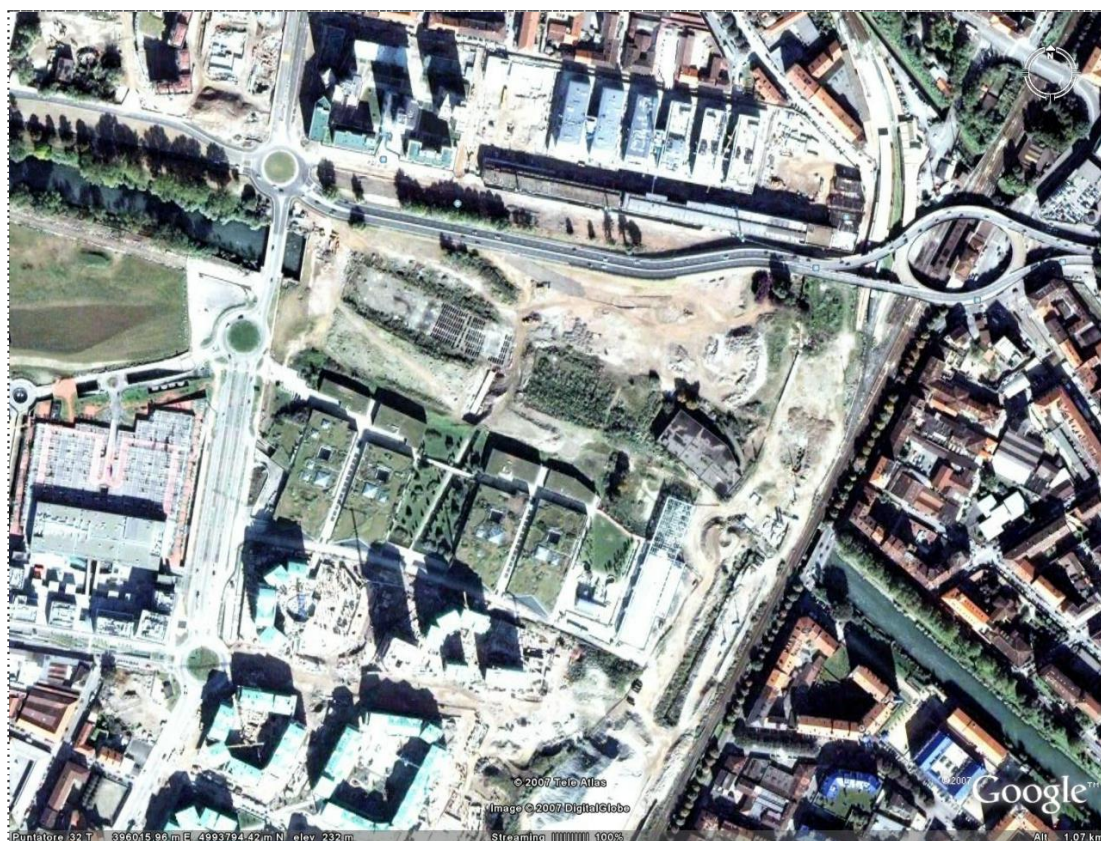
Figura 11. Un tratto della Dora Riparia coperto da una piattaforma industriale. Torino.
