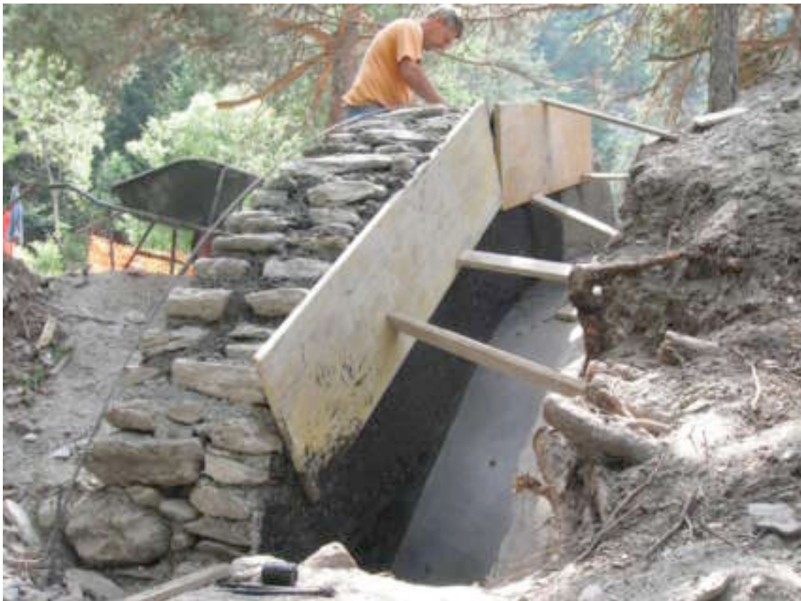
Ricostruzione delle parti di muratura in vista (2009)
