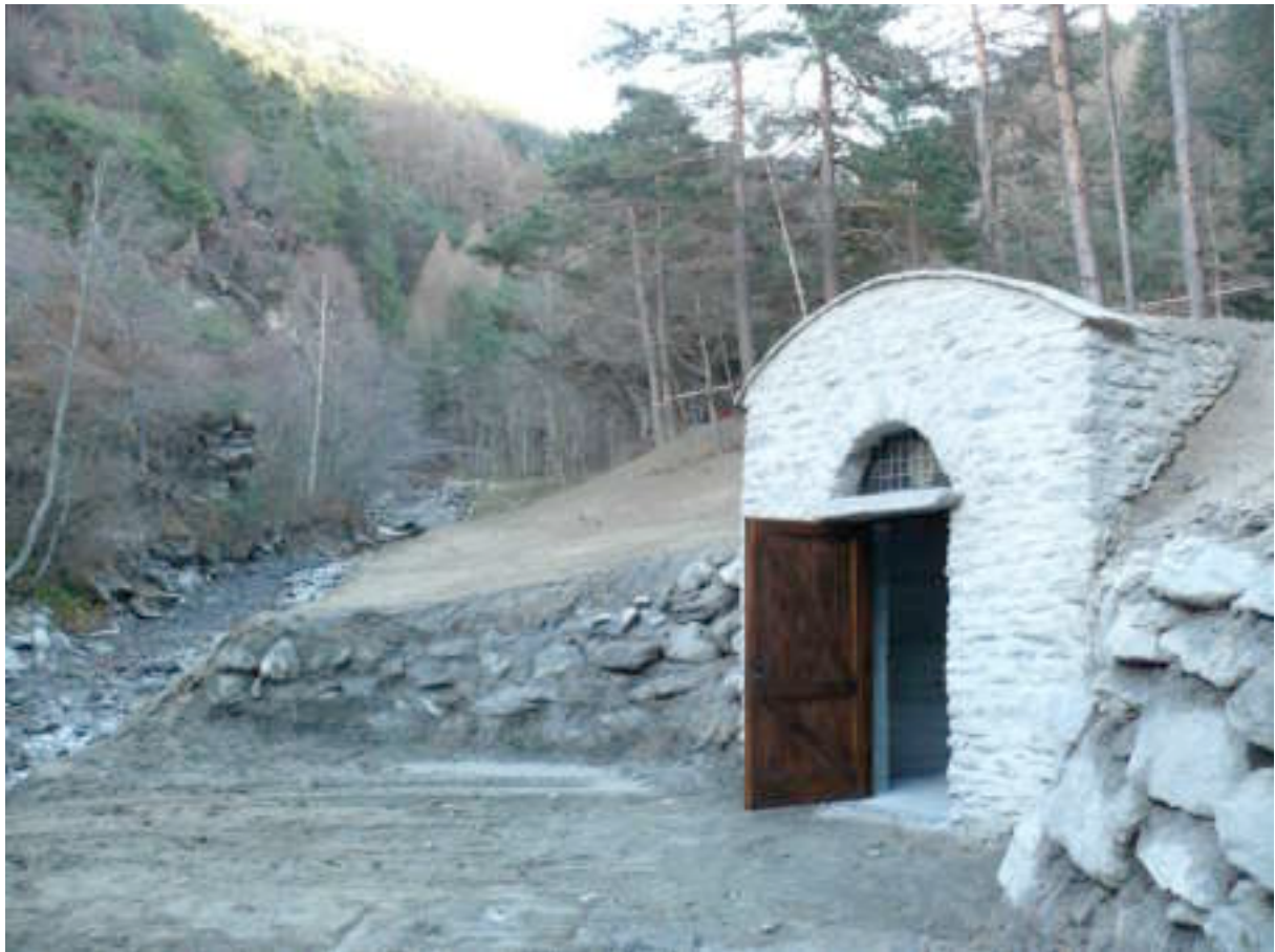
Locale tecnico per l'impianto di ventilazione meccanica della ghiacciaia (2009)
