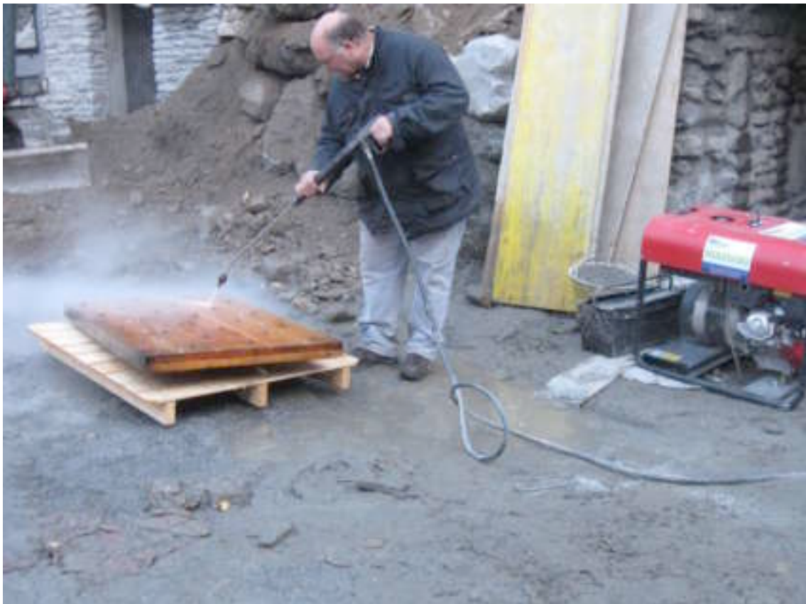
Pulizia e restauro dei serramenti lignei (2009)
