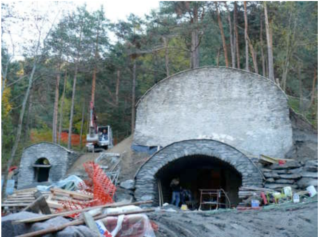
Attività di cantiere (2009)
