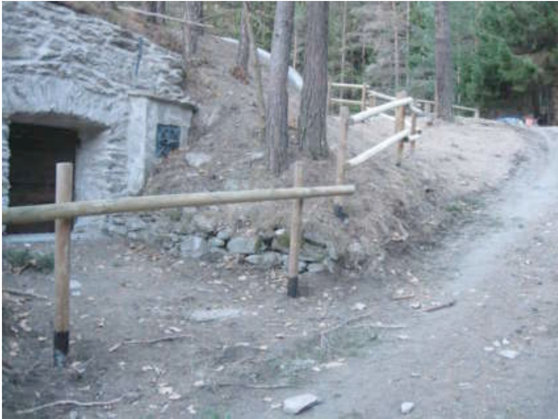
Staccionata di protezione in legno (2009)
