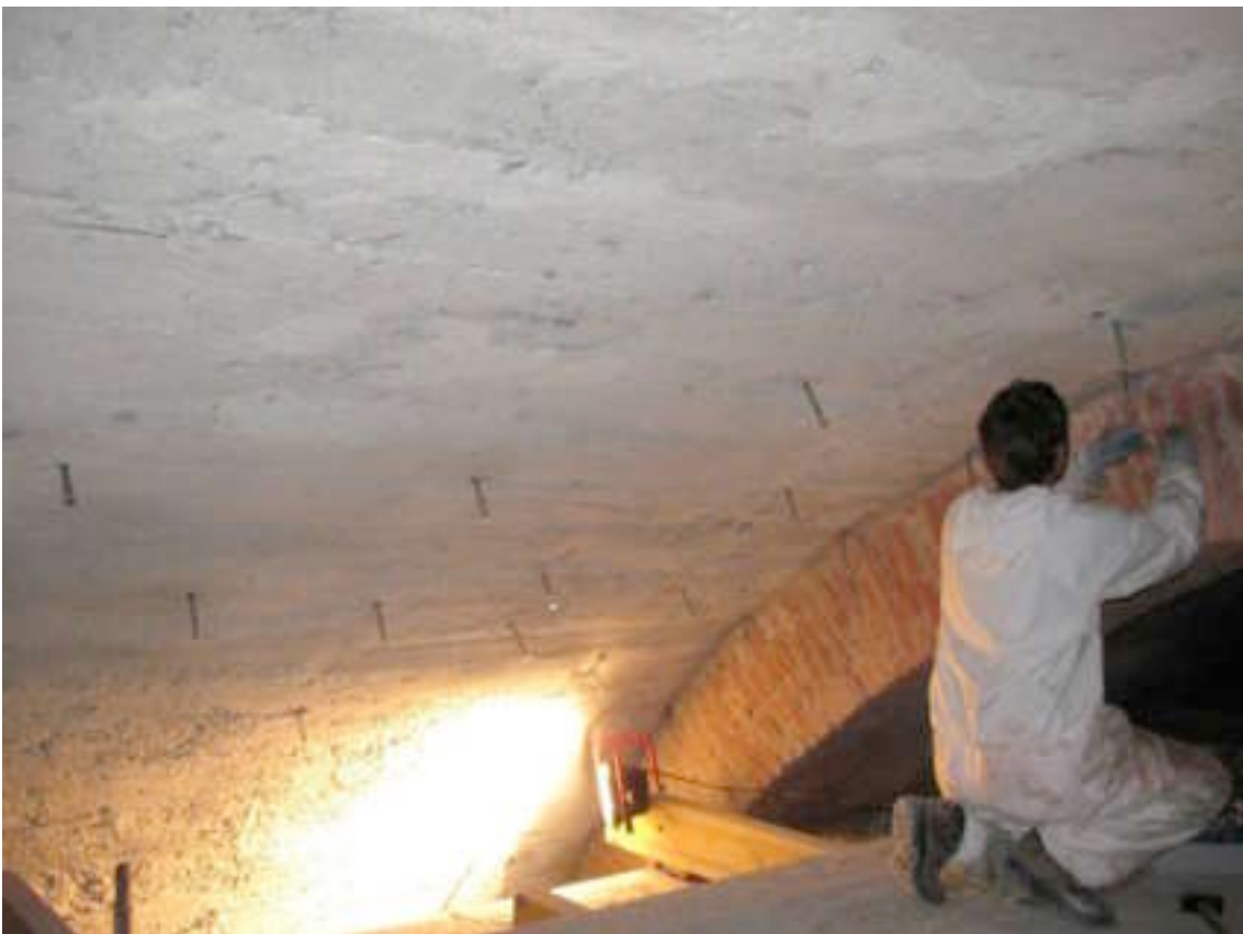
Fasi preparatorie per le iniezioni della resina impermeabilizzante (2009)
