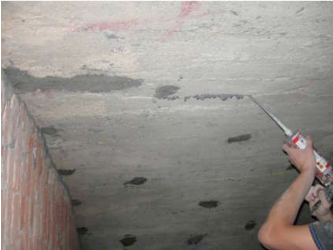
Stuccatura e sigillatura di fori e fessurazioni (2009)
