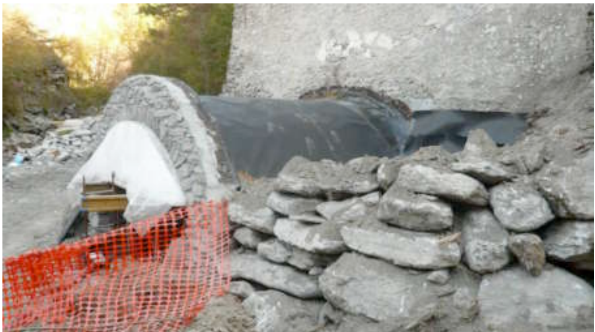
Impermeabilizzazione del nuovo voltino (2009)
