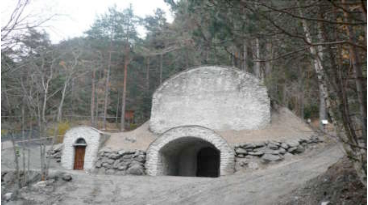
La facciata principale a lavori conclusi (2009)
