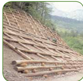
Grata viva semplice su scarpata in fase di costruzioni
