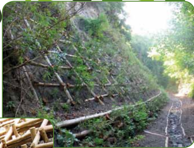
intervento di stabilizzazione grata con palificata su versante PARCO NAZIONALE DEL VESUVIO.
