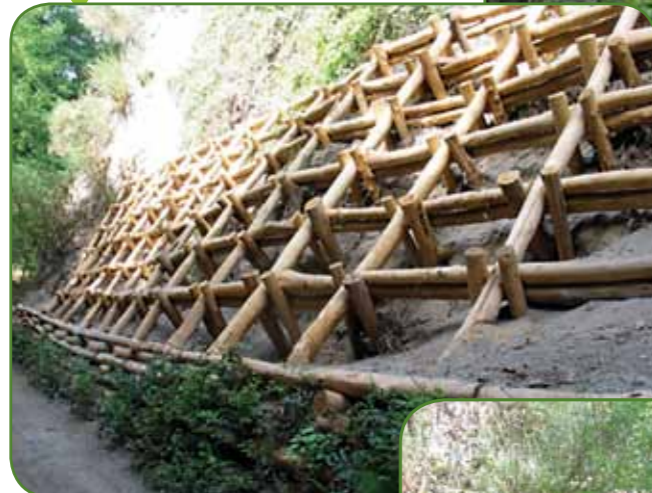
intervento di stabilizzazione grata con palificata su versante PARCO NAZIONALE DEL VESUVIO.
